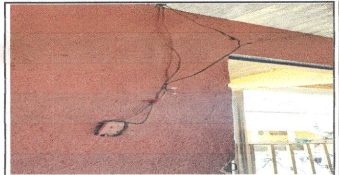
Foto 6: Reparación de cableado electrico
